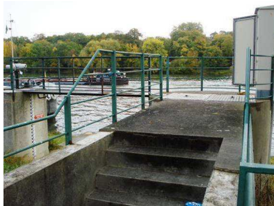
Poste anti-crue Apport Paris
