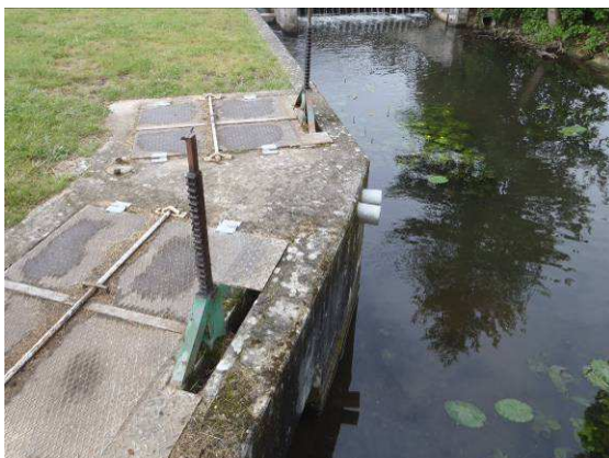
Vannes exutoires principaux
