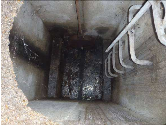
Vanne Port des Sabots
