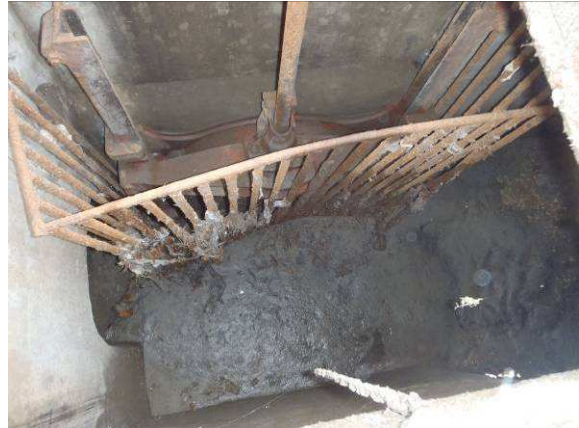
Vanne Poste anti-crue
